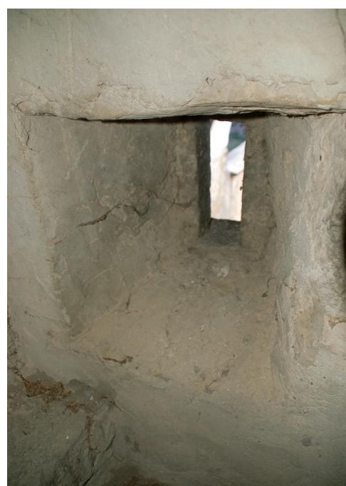
Aspillera en la torre.
