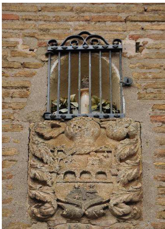
Escudo ubicado en la fachada principal
