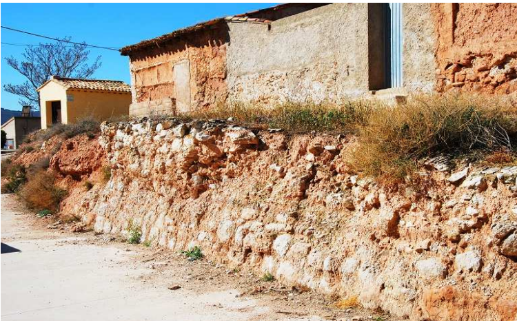
Tramo en la calle Soledad cercano a la iglesia
