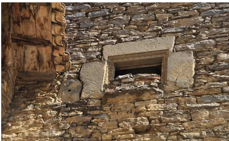
Detalle de vanos abiertos con tronera y aspillera
