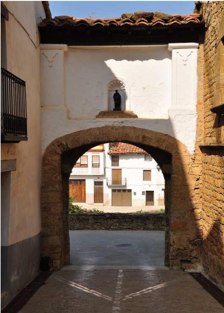
Detalle del portal intramuros
