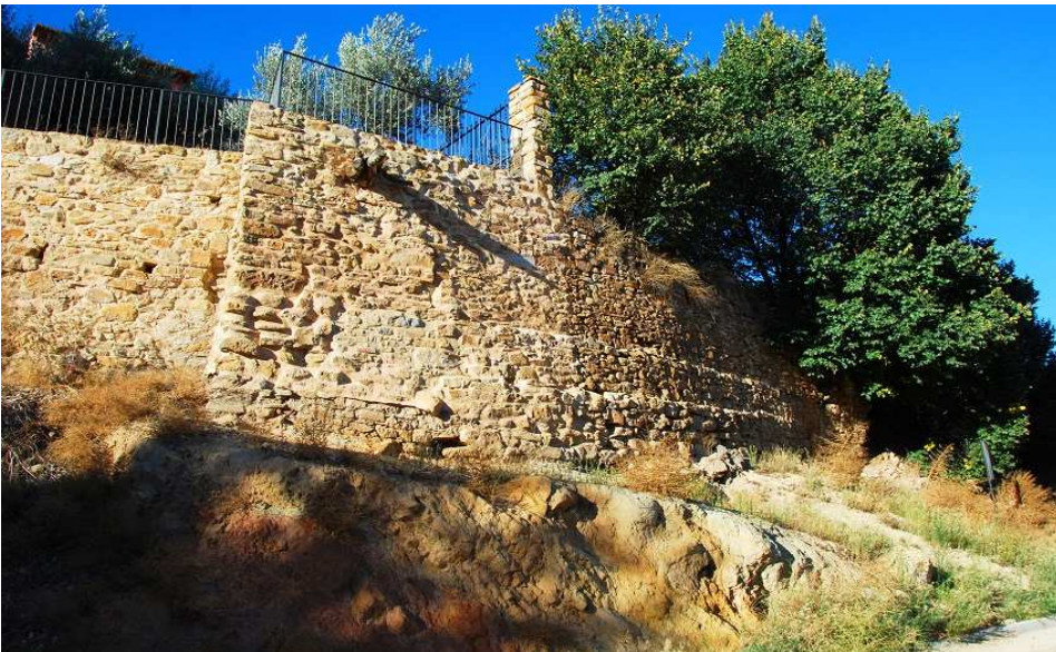
Restos de lienzo de parte de la muralla
