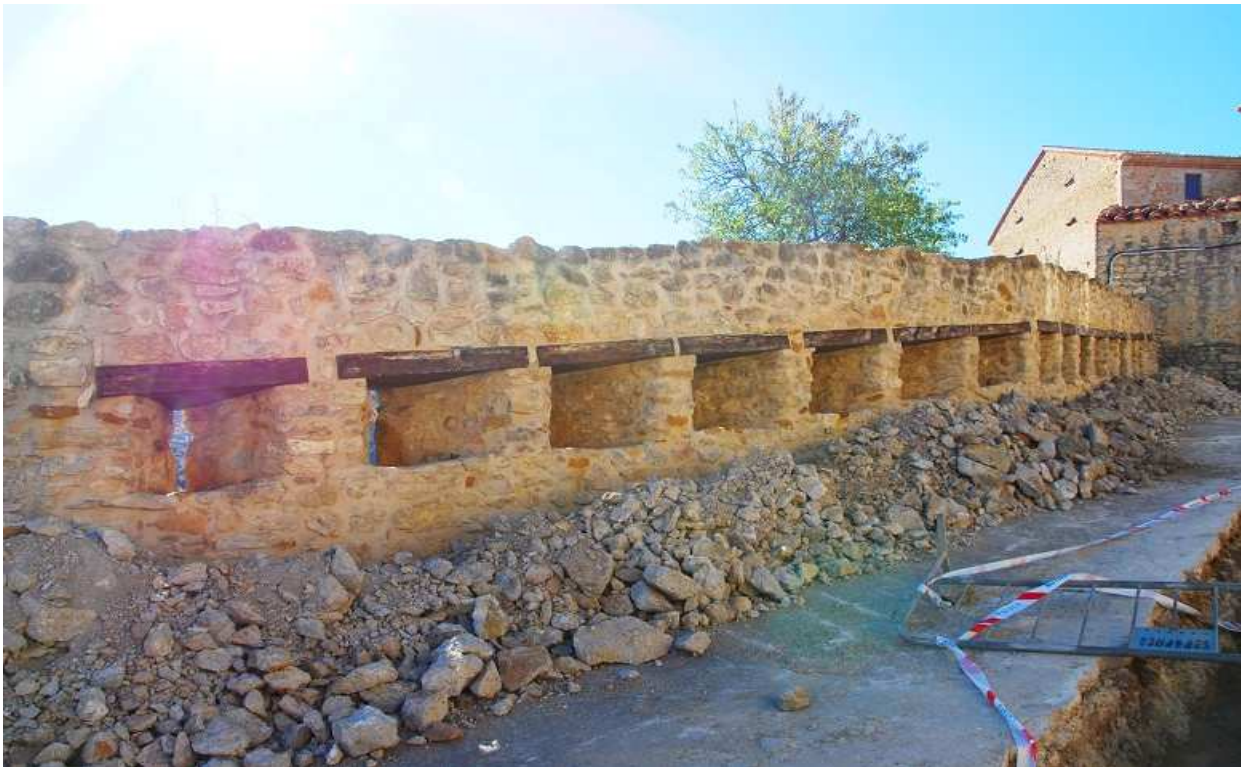
Muro E aspillerado. Época carlista
