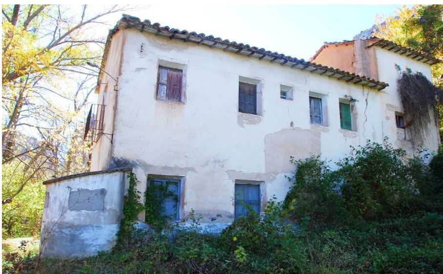
Vista de la central desde el río
